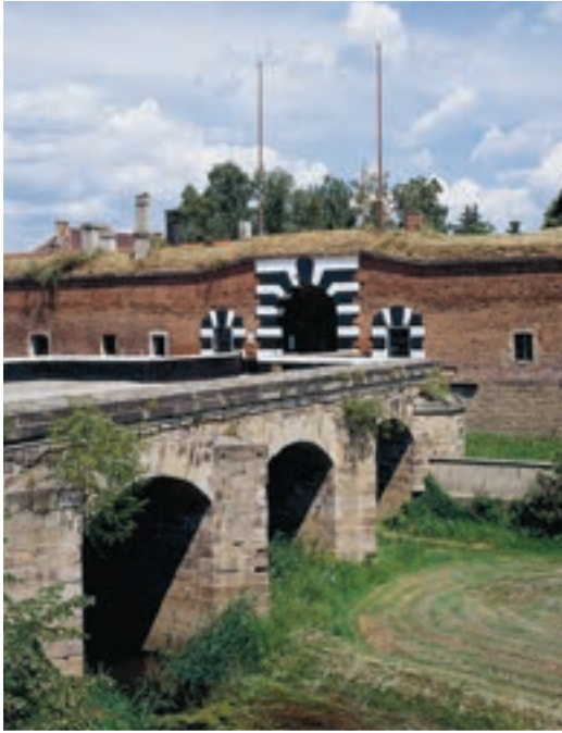
Hlavní brána Malé pevnosti, současný stav. Main gate of the Small Fortress, current status.
