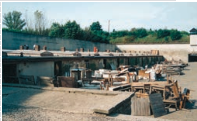
Povodeň 2002. Pohled na IV. dvůr Malé pevnosti po opadnutí vody.
